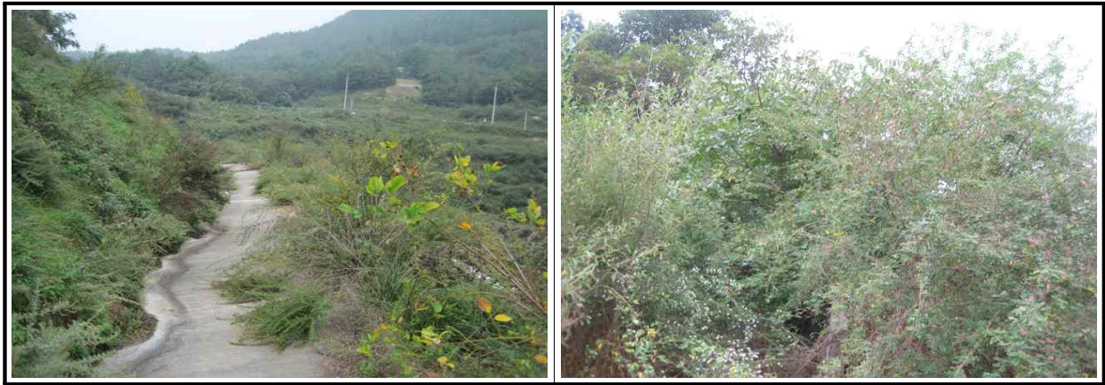
【그림 18.3.3】 배수시설 전경
