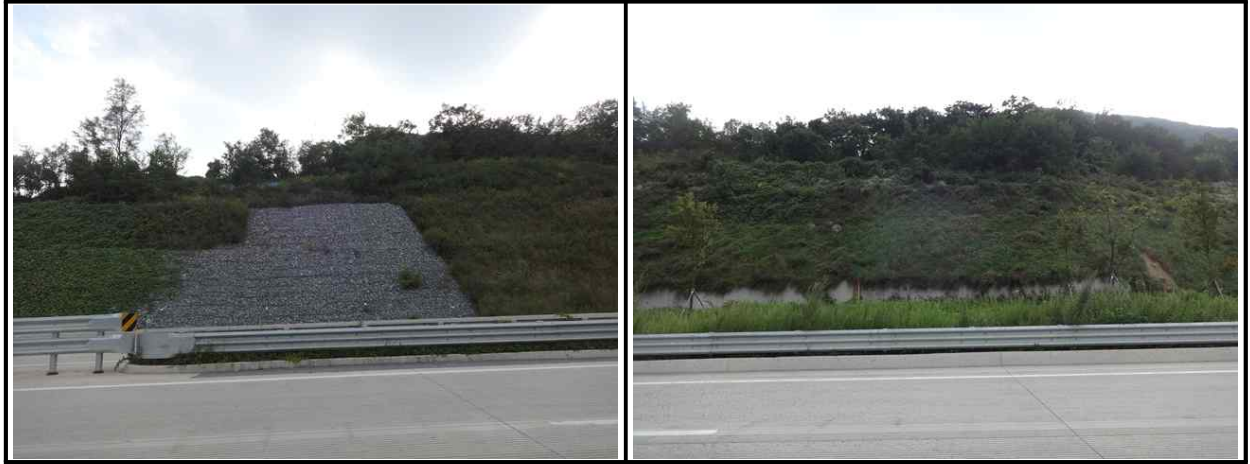
【그림 18.3.4】 보호/보강시설 전경
